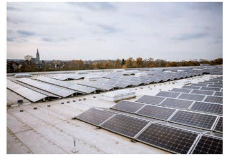
Die Photovoltaikzellen auf dem Dach des Lagers versorgen u. a. die OxyReduct®-Anlage mit nachhaltig produziertem Strom.
