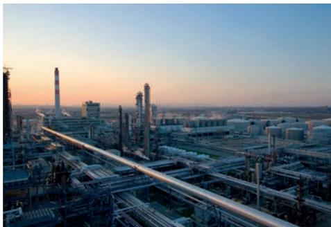
Die Kapazität der Pilotanlage wird bei 1,25 Mio. Liter Propanol pro Jahr liegen. Dies führt zu einer Reduktion von ca. 1.800 Tonnen CO<sub>2</sub>. Zur Herstellung eines Liters Propanol sind 1,2 Liter Rohglycerin notwendig. Unter moderaten Temperaturen und Drücken wird in dem energiesparenden Prozess ein Barrel
